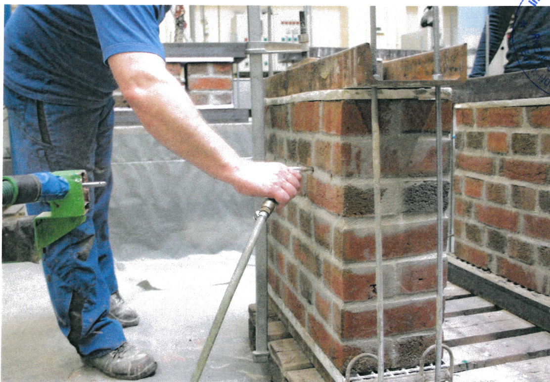
Bild B2: Ausblasen von Bohrmehlrückständen mit ölfreier Druckluft
