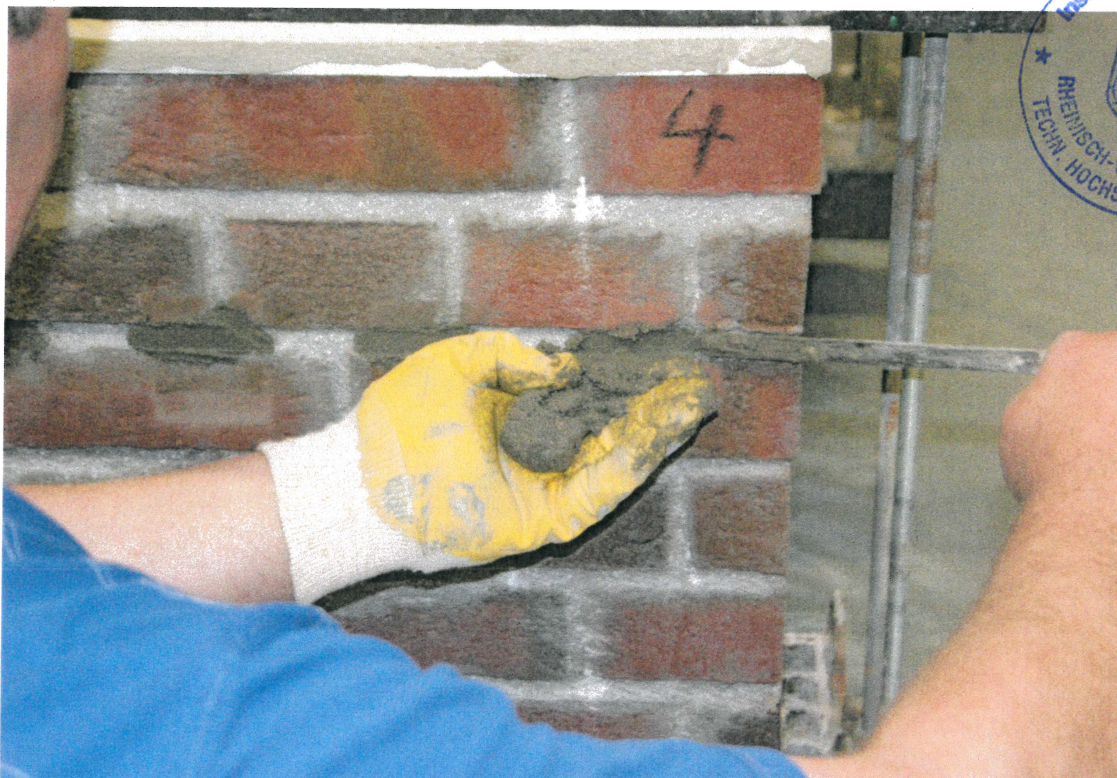
Bild B4: Verschließen der Injektionslöcher mit Schnellzement
